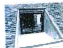
CREVEE DE TOITURE
